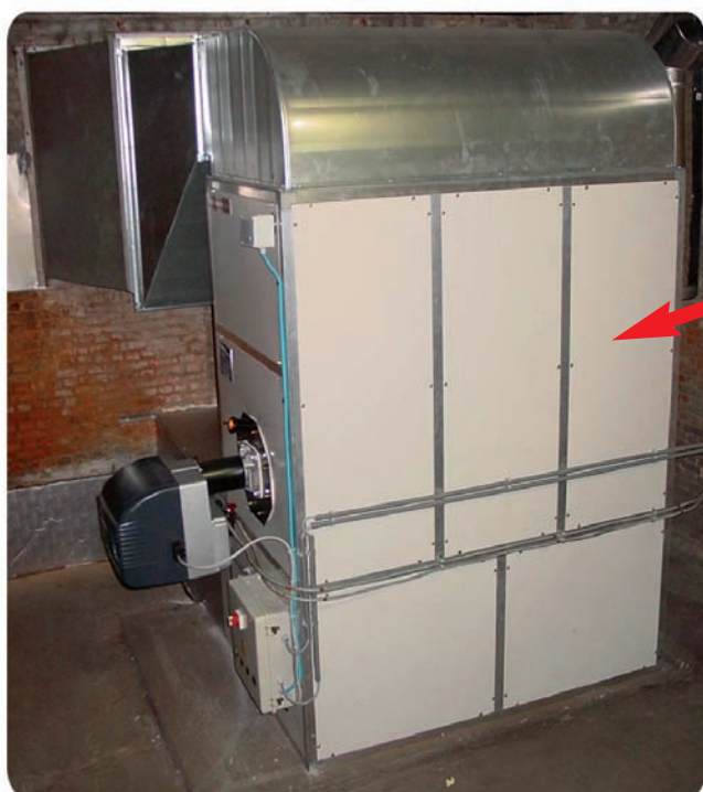
Nos appareils sont entièrement démontables (option). Dans cet exemple il s'agit d'un SES 300 démonté dans nos ateliers et remonté dans la chaufferie de l'Eglise Heilige Hart (Antwerpen).
